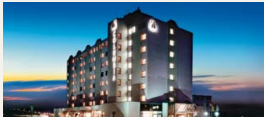
COLUMBIA Hotel Rüsselsheim Erstklassiges City-Hotel in exponierter Rhein-Main-Lage. First-rate city hotel in superb Rhine/Main location.
